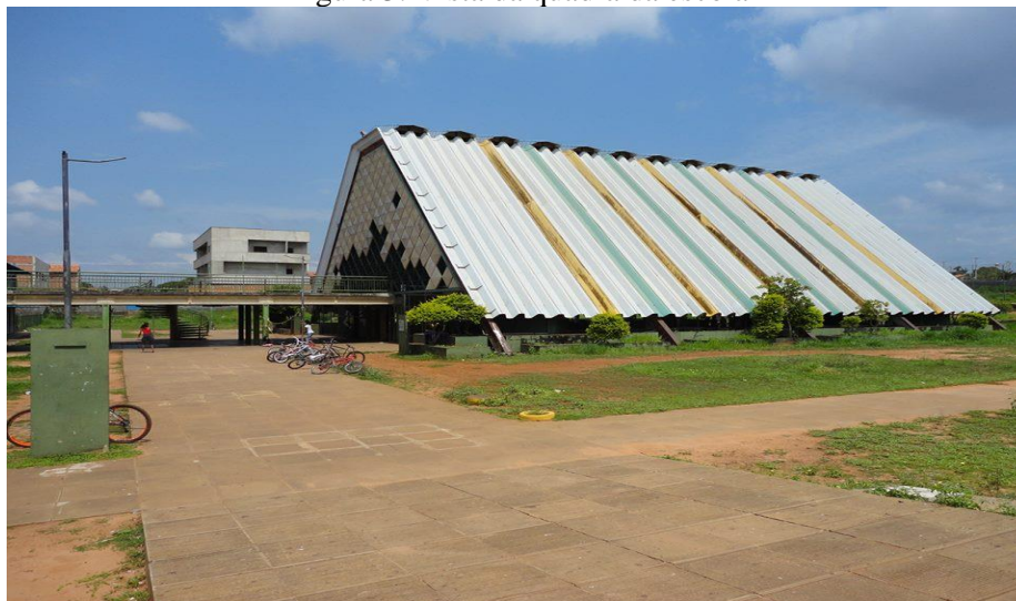
Figura 3: Vista da quadra da escola
